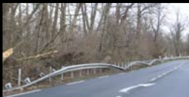
Les glissières totalement gondolées
